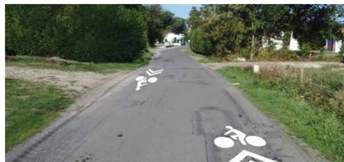
► Une signalétique pour sécuriser la cohabitation entre cyclistes et automobilistes
