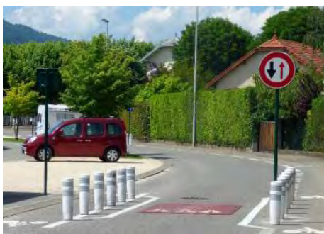
Écluse avec passage cycliste
